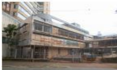
2015. Obra de Restaura. Fonte: Dir. de Pat. Histórico - PML
